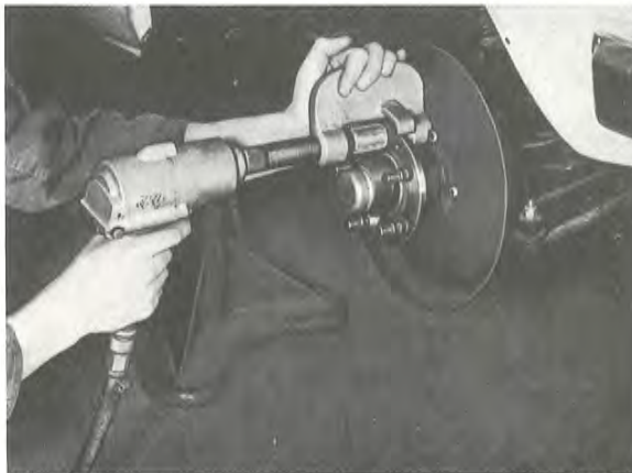
Bild 22. Montering av hjulbult
