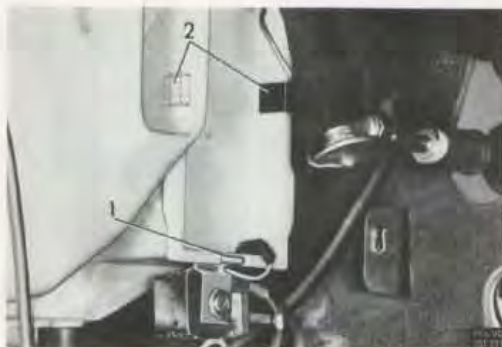
Bild 78. Demontering av förångarlock
