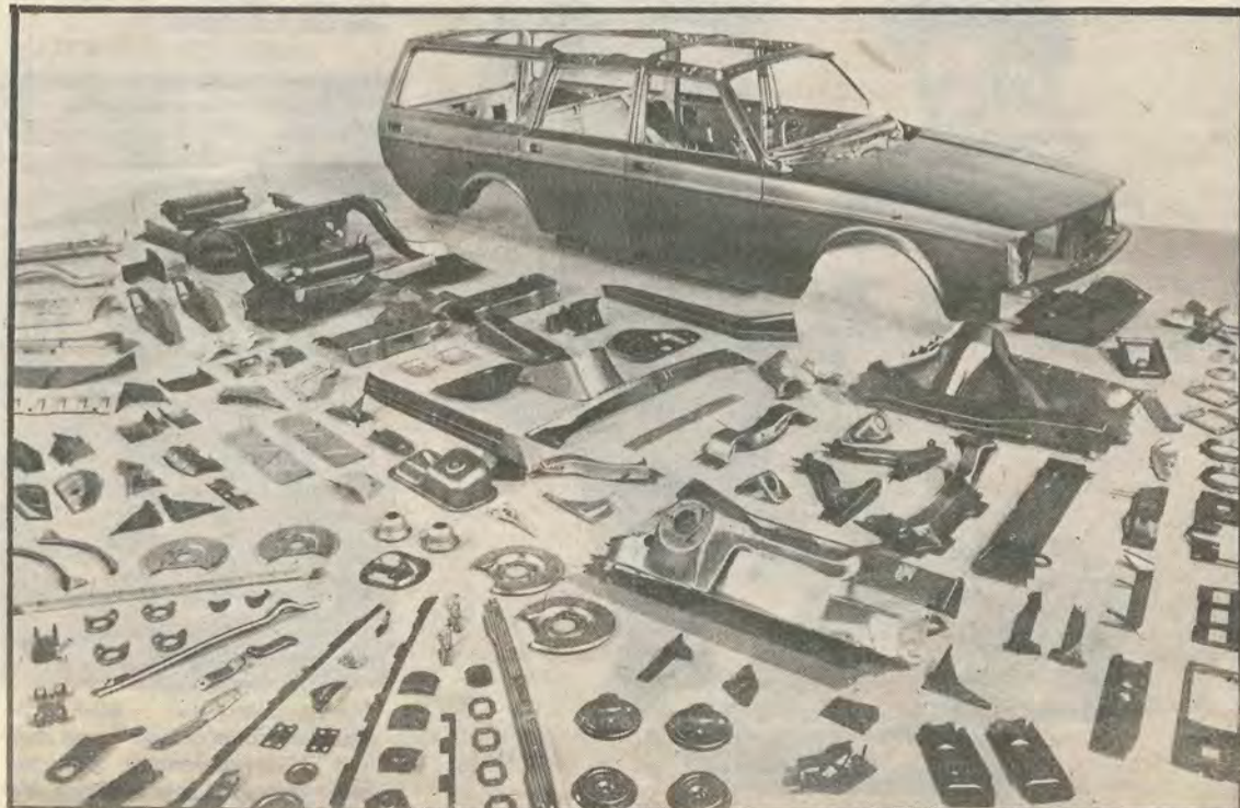
Vid Volvo Olofströmsverken tillverkas merparten av alla plåtdetaljer som ingår i bilen. Här är det en 245:a som "exploderat".
