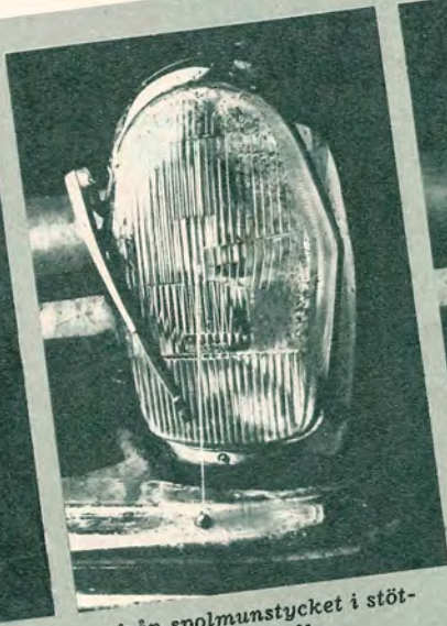
... och torkarmen svänger ut och torkar av smutsen med flera dubbelslag...
